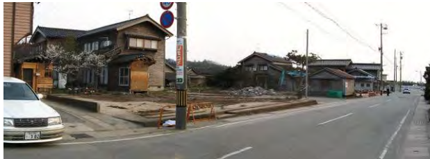
図3 調査位置の2007年4月8日の状況（道路左の倒壊家屋はすでに撤収されている。）
