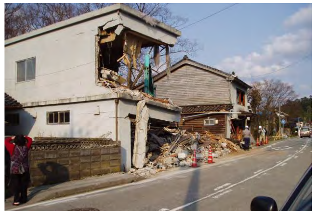
図3 輪島市門前町館での被害（多くの家屋が東西方向に倒れた）
