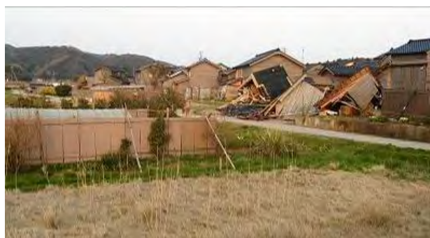
図7 道下北部の微高地下の低地での被害
