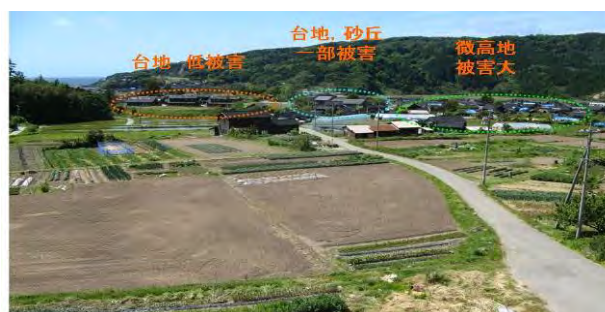
図9 道下の南から見た微高地と被害状況
