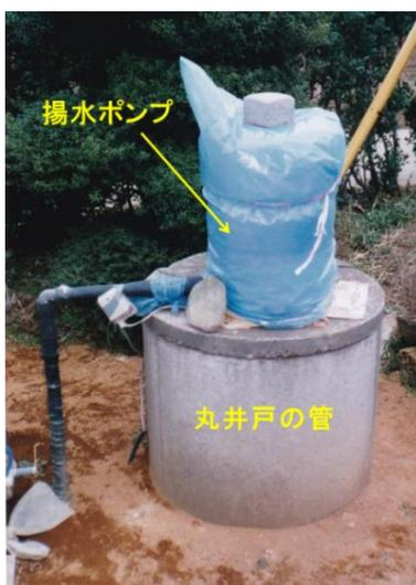
図 I-2 電動の揚水ポンプでくみ上げている丸井戸の例
