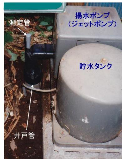
図 I-16 揚水井に取り付けられた測定管の例
