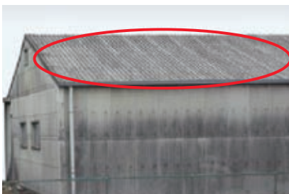
屋根に使用した例(成形板波板)
