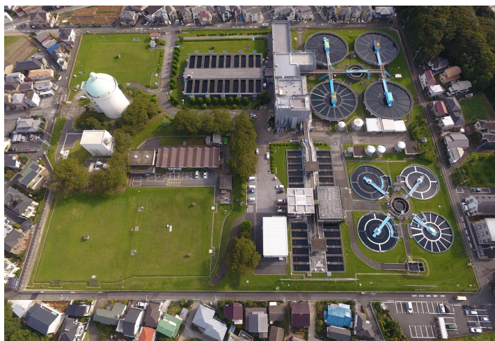
栗山給水場 (旧栗山浄水場)
