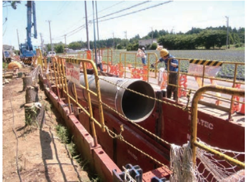
用水路（パイプライン）道路に管を埋める工事の様子
