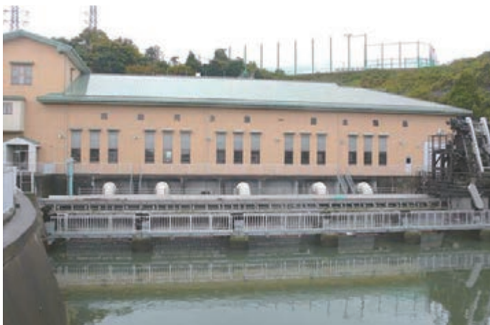
香取市にある両総第一揚水機場
