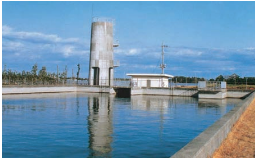
とうそう ようすい 東総用水のファームポンド (すいりょうちようせい しようためいけ) (水量調整用の小溜池)
