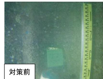
調査の結果、鋼矢板の腐食を確認
