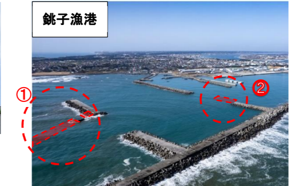
①沖南防波堤・②黒生東突堤の状況
