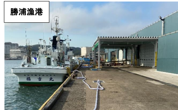
－6.0m岸壁（耐震強化岸壁）の状況
