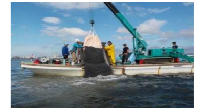
覆砂・砕石覆砂(三番瀬地区)
