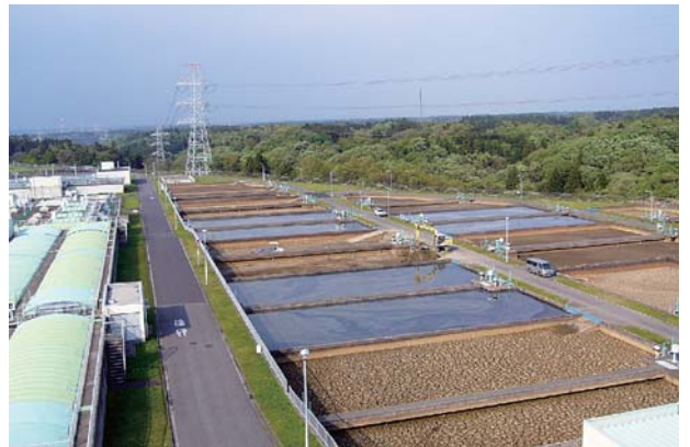
【福増浄水場の天日乾燥床】
