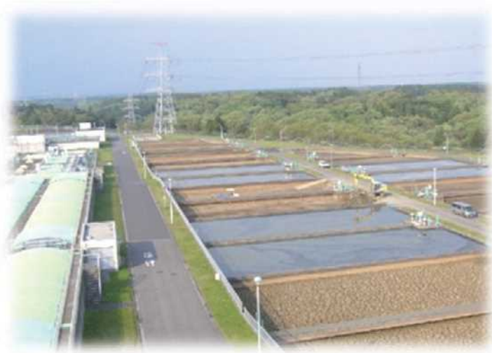
福増浄水場での浄水発生土の天日乾燥
