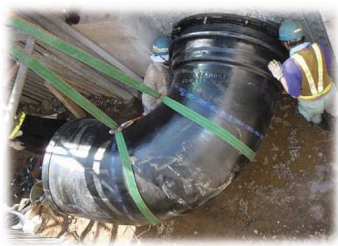
配水管布設替工事
