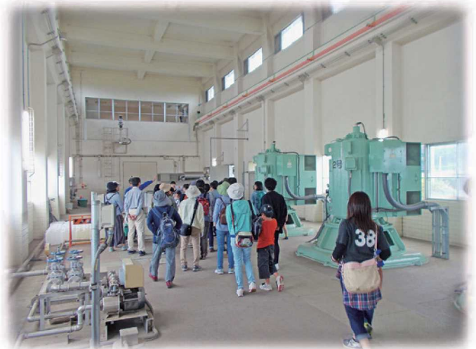
取水場 ポンプ見学の様子
