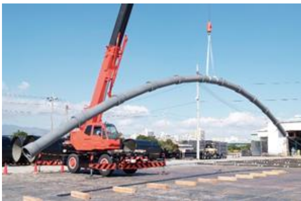
（日本ダクタイル鉄管協会提供）
