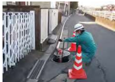
図5－11 水道管の洗浄作業
