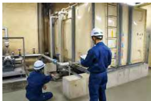
図5-12 貯水槽施設の点検
