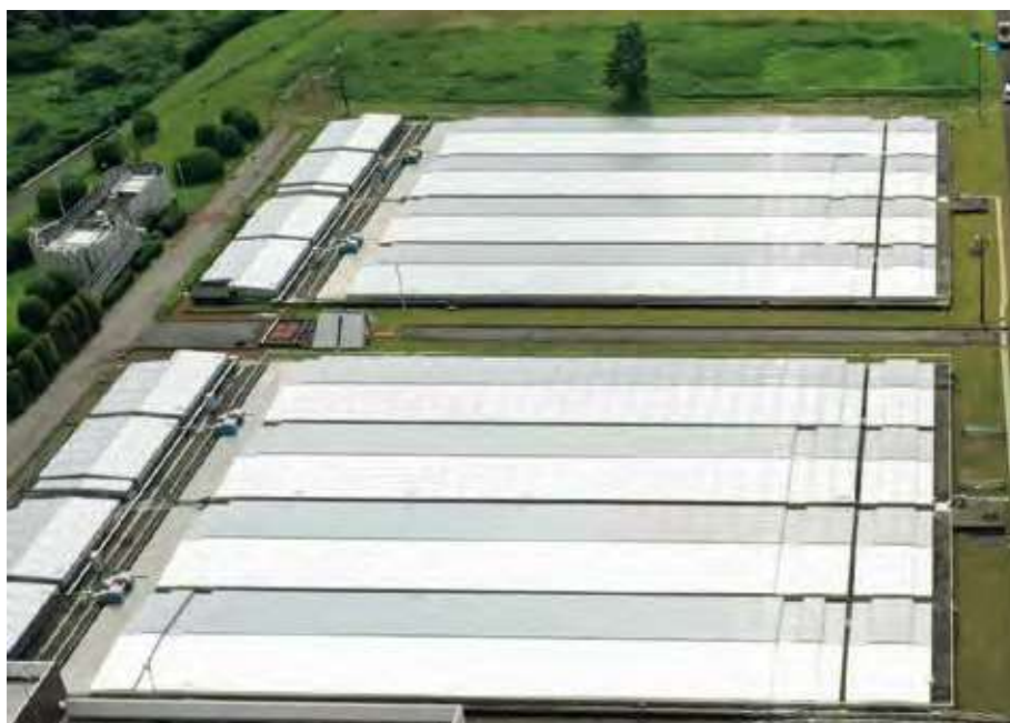
図3－7 浄水場の覆蓋化
