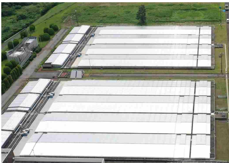
図3-7 浄水場の覆蓋化
