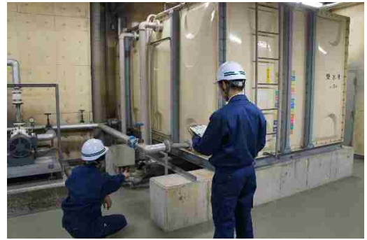
図5-12 貯水槽施設の点検
