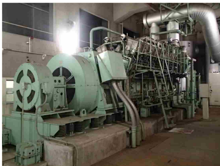
図5-3 非常用自家発電設備
