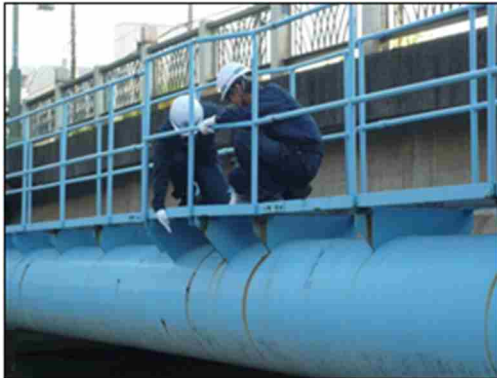
図3-2 管路パトロール
