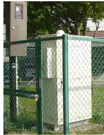
図5-10 水質自動監視装置
