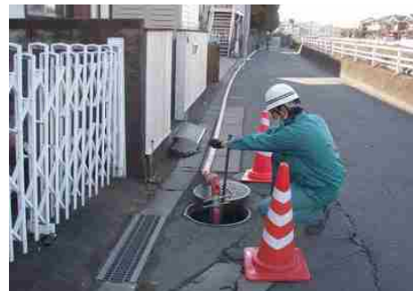
図5-11 水道管の洗浄作業
