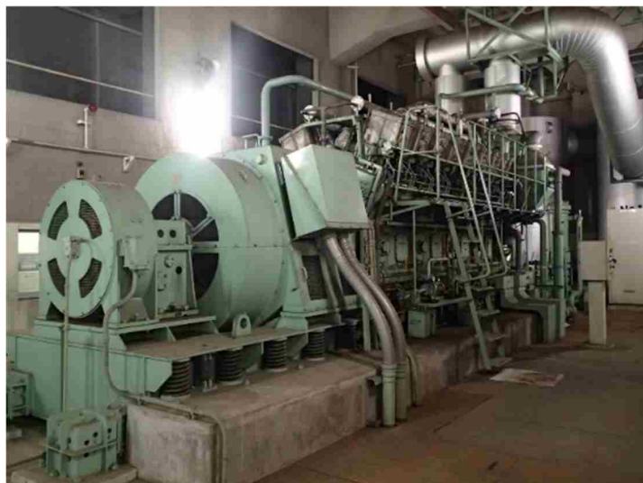
図5-3 非常用自家発電設備
