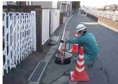
図5-11 水道管の洗浄作業
