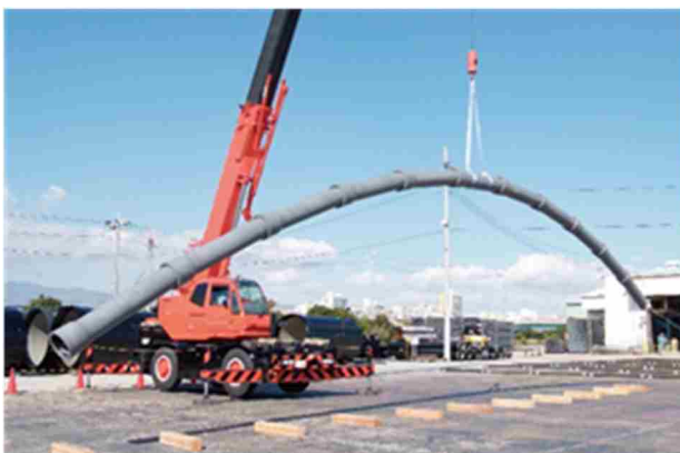
（日本ダクタイル鉄管協会提供）
