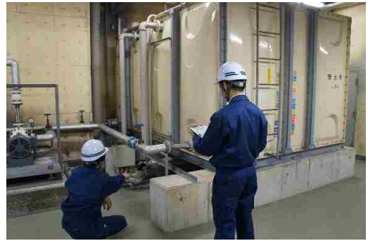
図5-12 貯水槽施設の点検
