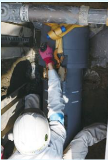
管路工事の様子 (器具を使った接合を上から見た様子)
