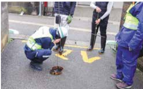
音聴棒による漏水調査
