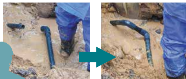
漏水修繕工事
