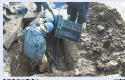
当時の工事の様子
