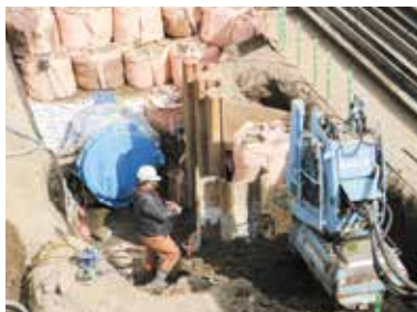
場内配管整備1-2
