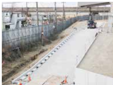
場内通路整備
