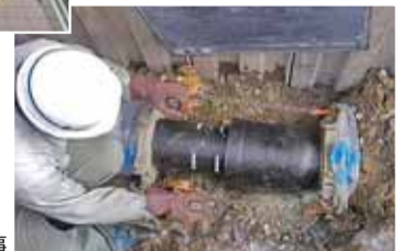
耐震継手を採用した管路の工事
