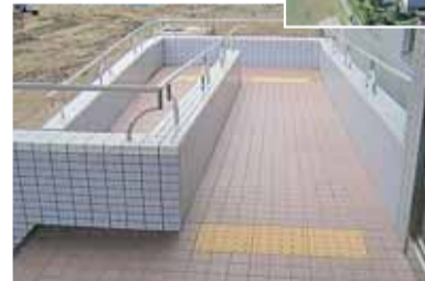
バリアフリー化したスロープ
