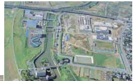
ちば野菊の里浄水場
