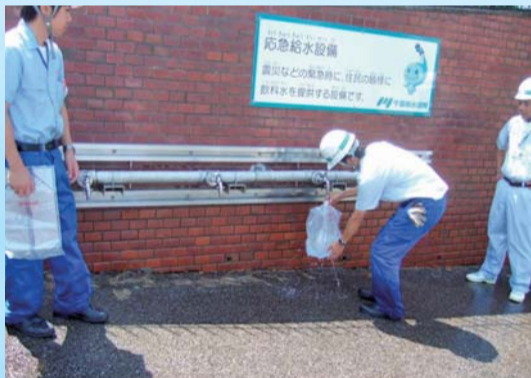
応急給水設備からの給水
