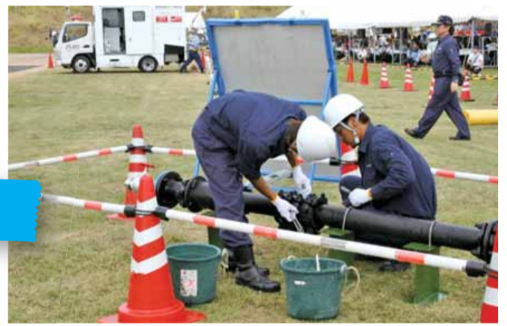
平成24年度九都県市合同防災訓練での応急復旧訓練
