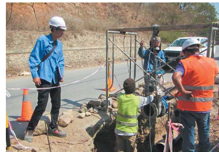
水道管工事の指導
