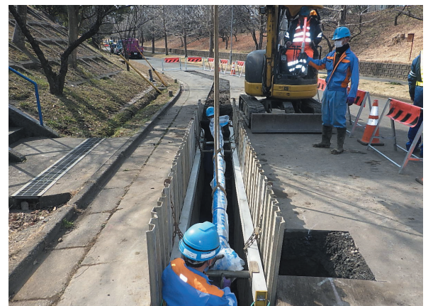
取替工事の様子
