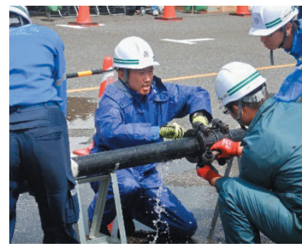
ライフライン施設応急復旧訓練
