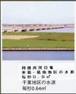
栲根川河口堰 全県・臨海地区の水源 毎秒0.8m 3 千葉地区の水源 毎秒0.64m 3
