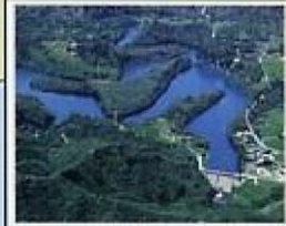
曹英ダム(重力式コンクリートダム) 木更津南部地区の水源 有効貯水量 420万m 3 毎秒1.06m 3 給水能力 日量8.5万m 3
