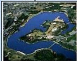
山倉ダム(アースダム) 五井市原地区の水源 有効貯水量 440万m 3 毎秒1.5m 3 給水能力 日量12万m 3
