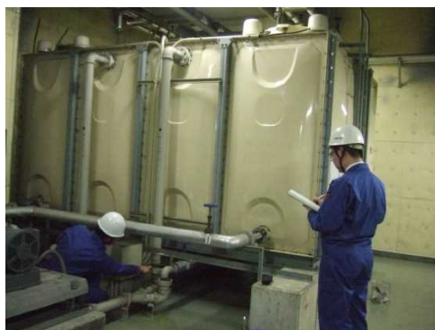
貯水槽の点検の様子
