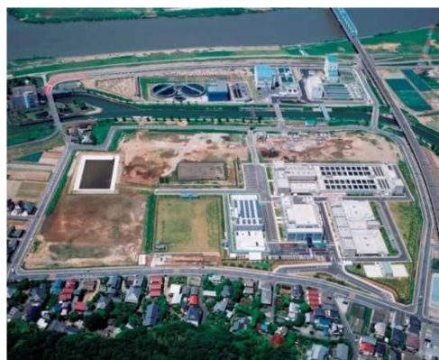
ちば野菊の里浄水場
