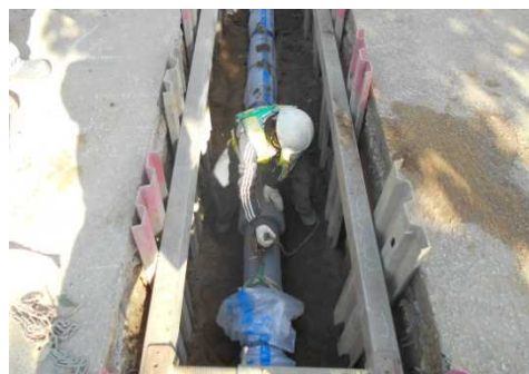
配水管の布設替の様子
