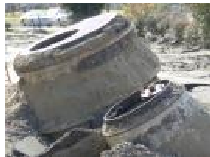
液状化で破壊した耐震性貯水槽
