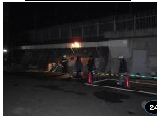
妙典給水場での給水への
