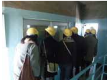
配水塔内部（最上階）
