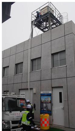
各応援事業体は、被災事業体である東京都水道局に向かい、東京都の被災情報を把握するとともに、関東地方支部内の都県支部毎に応急給水場所の割り振り（応援活動審議訓練）を行い、誘導に従い給水車を移動し加圧ポンプを稼働させて高架水槽まで水の圧送を実施しました。（応急給水訓練）
