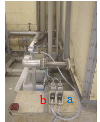
⑥残留塩素計 測定部
