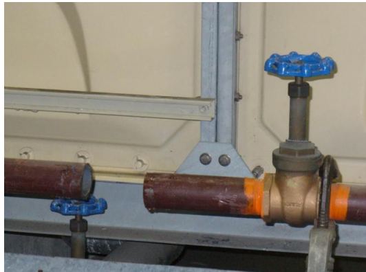
③鋼管の切断
