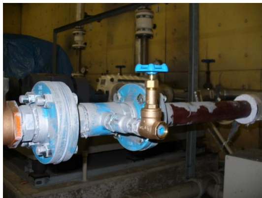
⑤サンプル分岐用T字管の設置
