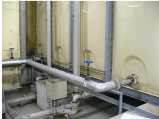
①工事前 (水道局幕張庁舎 地下受水槽)
