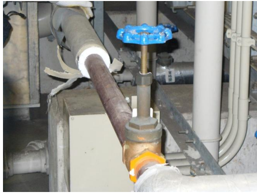
②保温材の撤去
