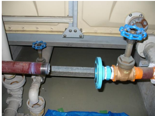
④ねじ切りとフランジの取付け
