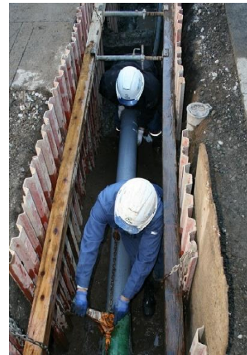
図V—7 配水管の布設替えの様子
