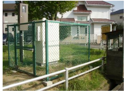
図V—6 水質自動監視装置
