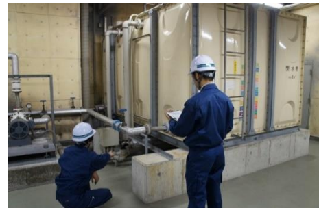
図V—8 貯水槽の点検の様子
