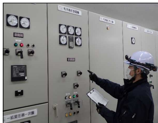
図9 職員による設備点検
