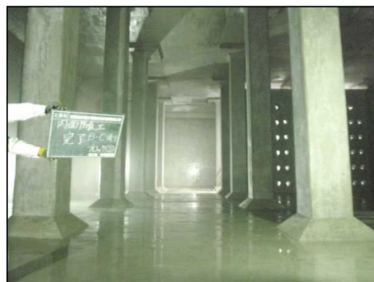
図11 配水池の防水塗装
