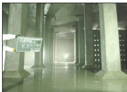
図7 配水池の防食塗装
