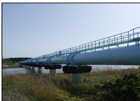
図 12 水管橋の防食塗装
