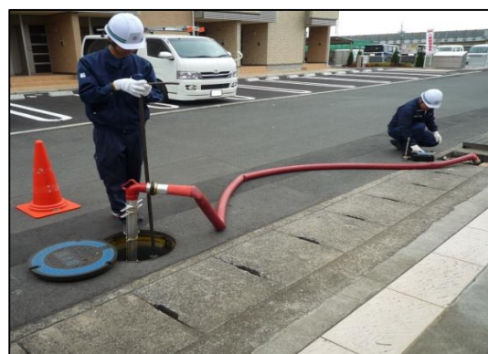
図 13 管内洗浄の様子
