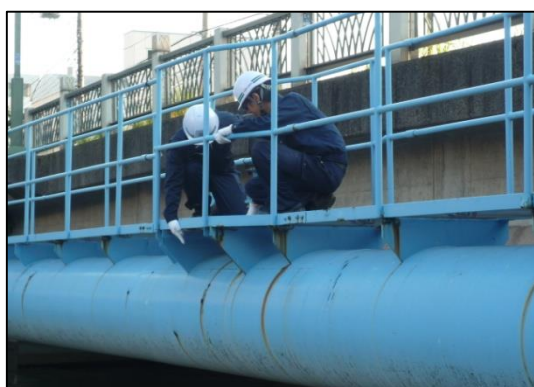
図 10 管路パトロールの様子
