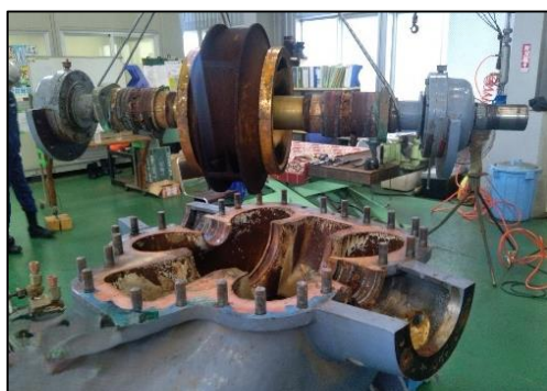
図8 機械設備の分解整備
