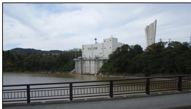
高滝取水場 (高滝ダム)
