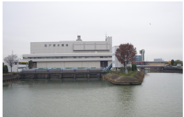
松戸排水機場 (坂川)
