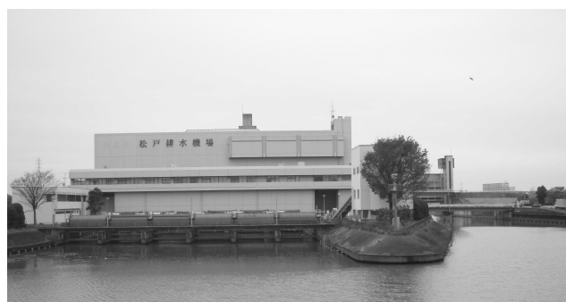
松戸排水機場 (坂川)
