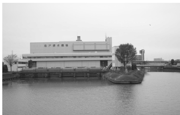
松戸排水機場（坂川）
