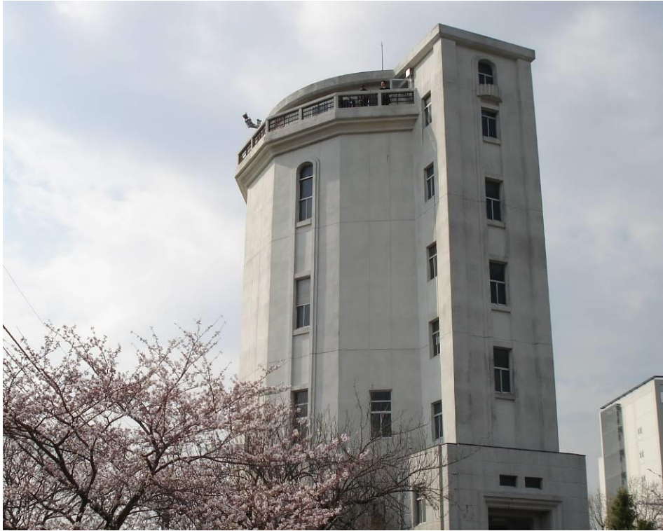
千葉分場高架水槽（土木学会選奨土木遺産・登録有形文化財）
