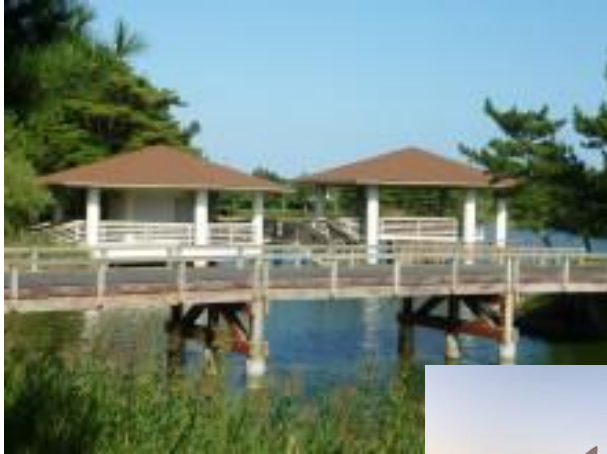
水の広場 (一般園地) ボートハウス・柵等の老朽化
