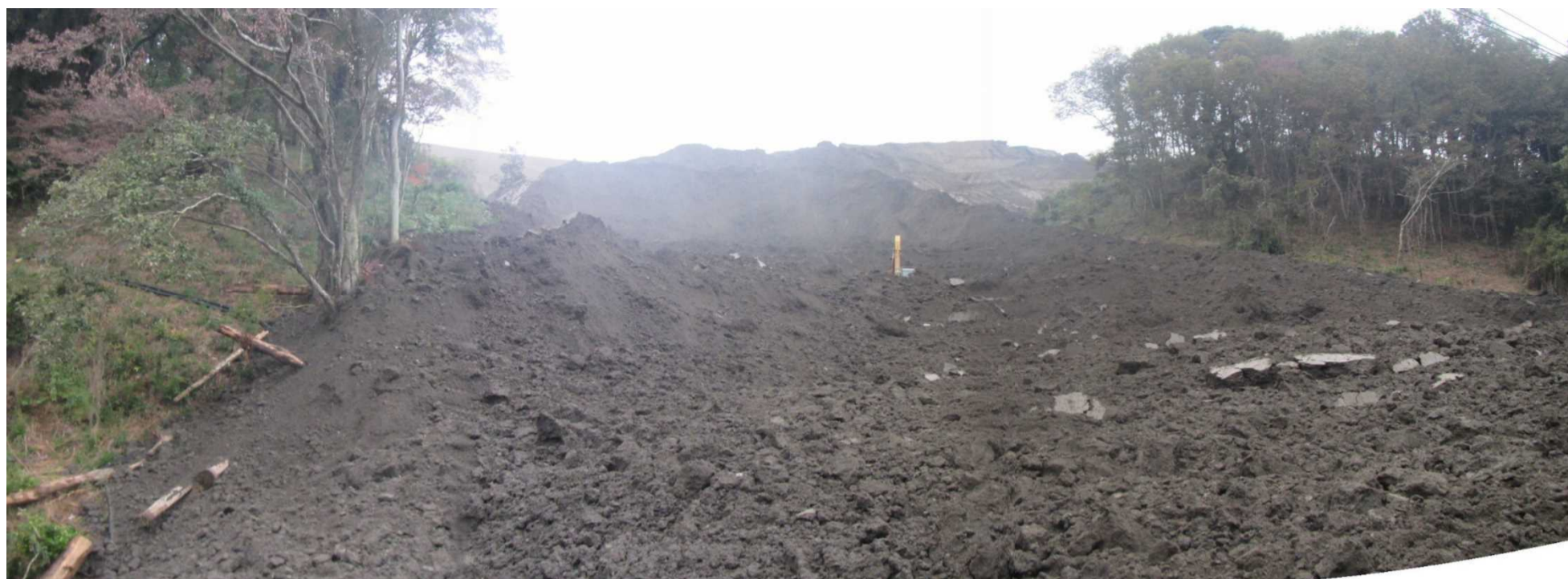
1 1月6日 施工地（土砂崩落状況）
