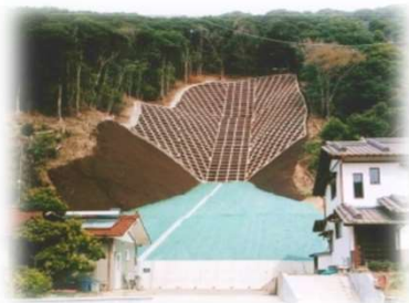
治山施設の設計施工管理
