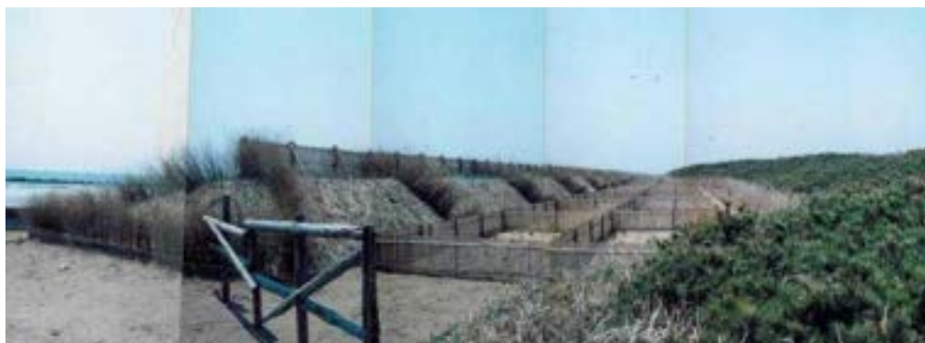
砂丘工～木製防風工～植栽（旭市三川）
