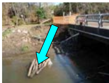
護岸工の損傷（山武市）
