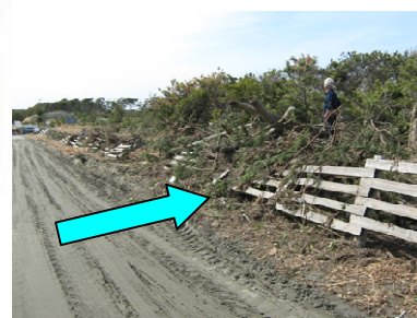
防風柵の倒壊（旭市）
