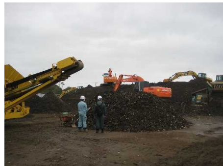
災害廃棄物の仮置場の様子
