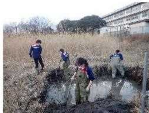
ビオトープ整備
