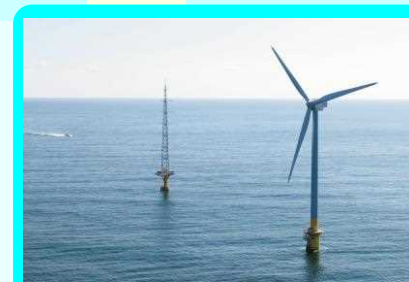
銚子沖洋上風力発電所
