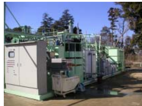
発酵(消化)液浄化処理工程
