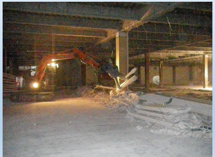
A L C 撤去状況
