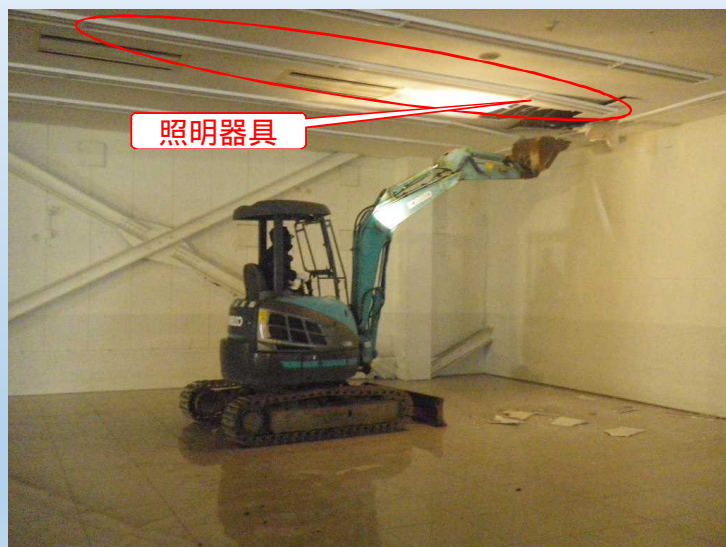
石膏ボード撤去状況
