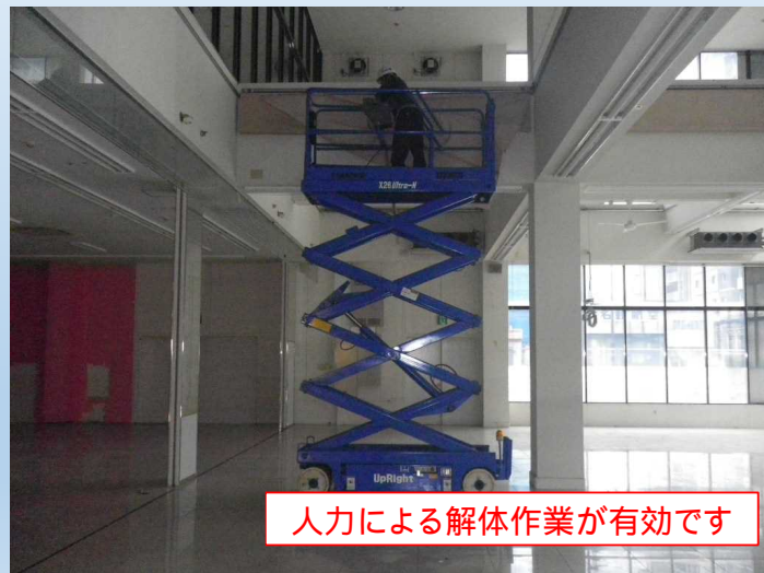
石膏ボード撤去状況
