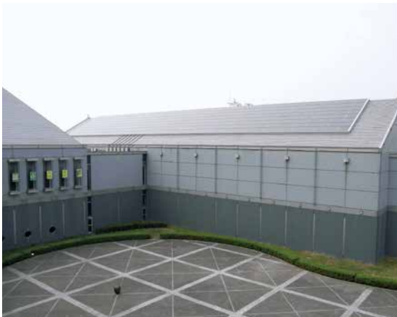
現代産業科学館の太陽光発電装置
