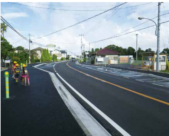
通学路の歩道整備
